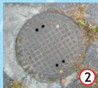
KLAPA KANALIZACYJNA Z 1939 R.
